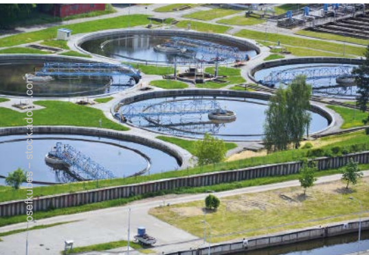
Wasserversorgung: Aufbereitungsanlagen, Pumpstationen, Speichertanks und Reservoirs müssen gesichert und überwacht werden
