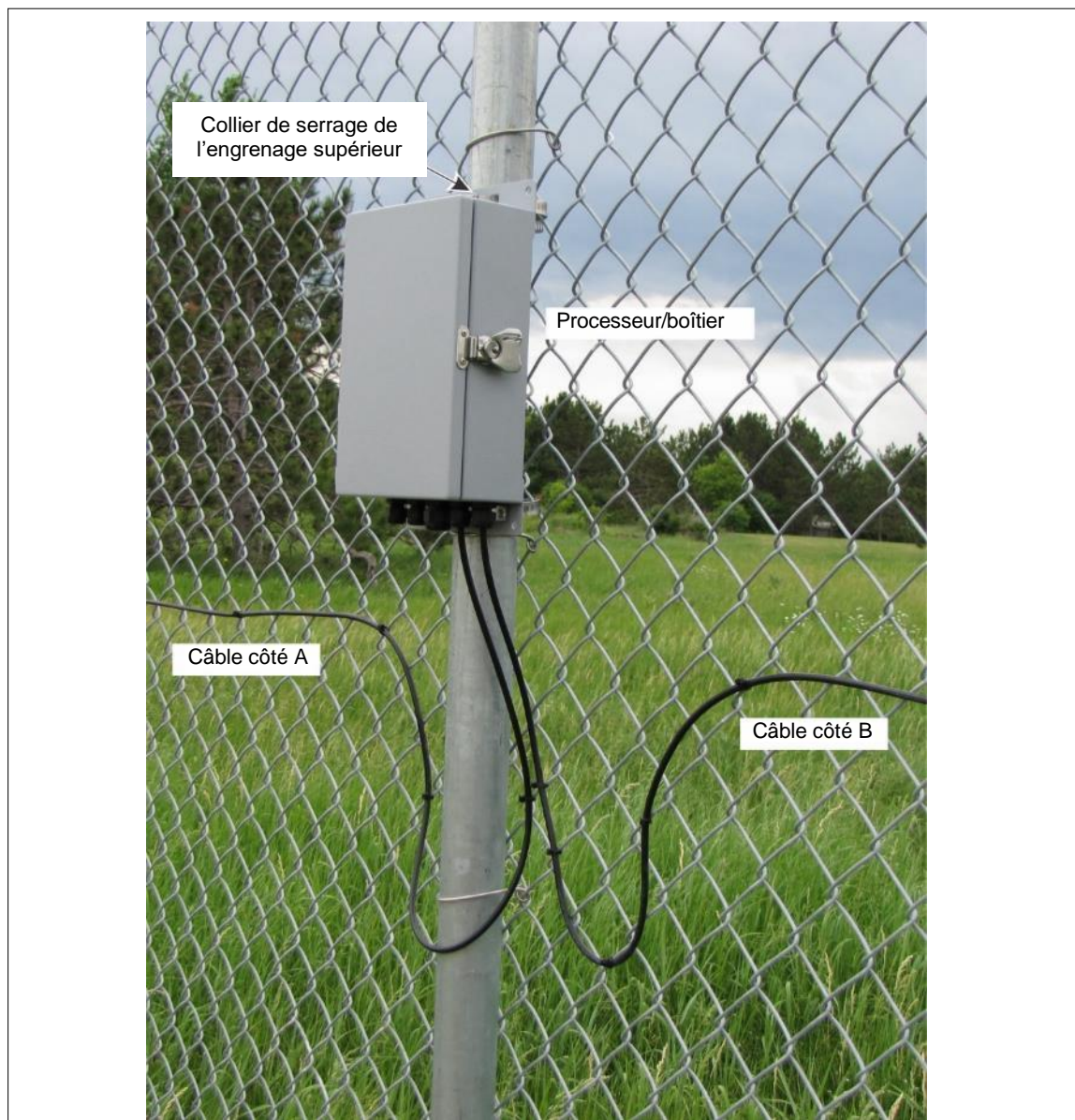
Figure 62 : Processeur FlexZone à passage unique et double zone monté sur clôture
