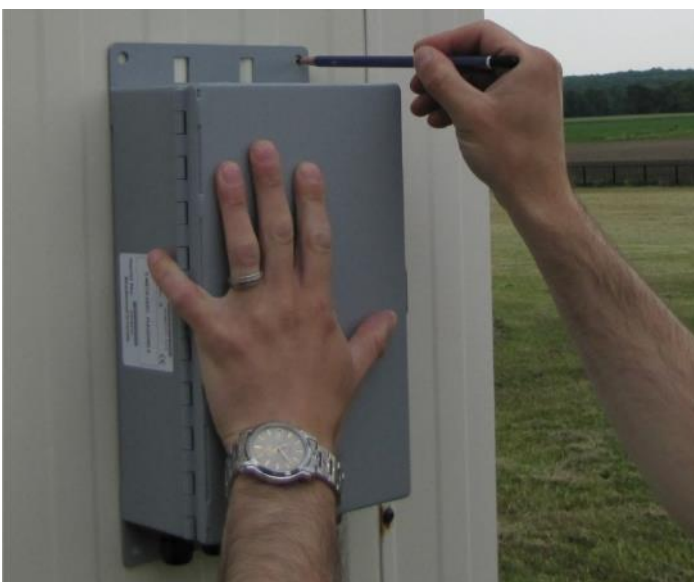
Figure 64 : Montage en surface du boîtier
