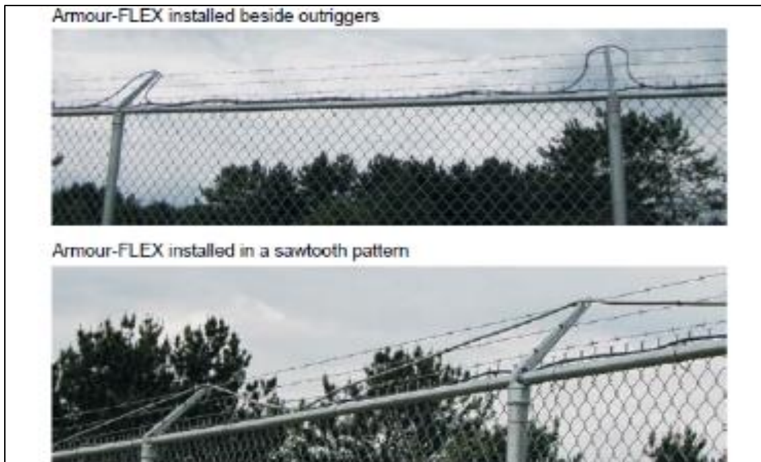
Imagen 3: Instalación de Armour-FLEX en alambre de púas (2 métodos).
