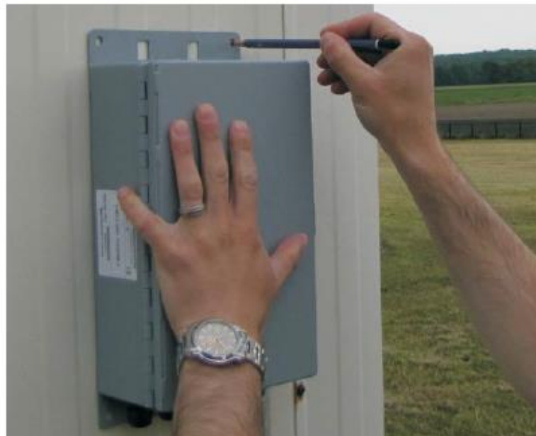
Imagen 53: Montaje superficial de la carcasa.
