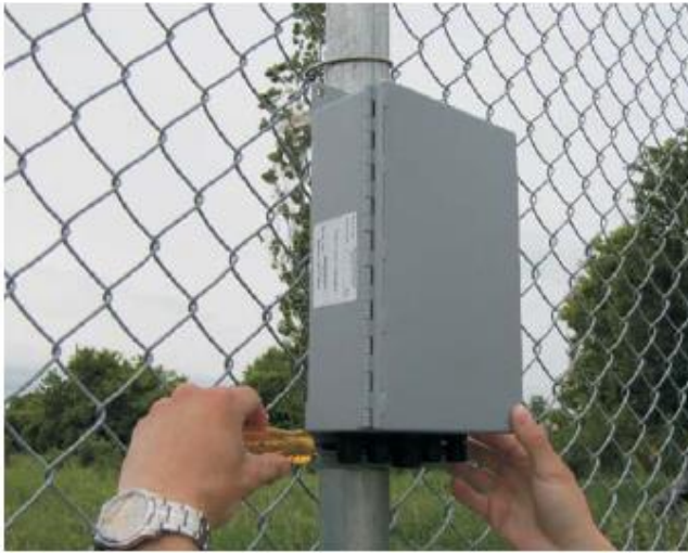
Imagen 52: Montaje posterior de la caja (en la cerca)
