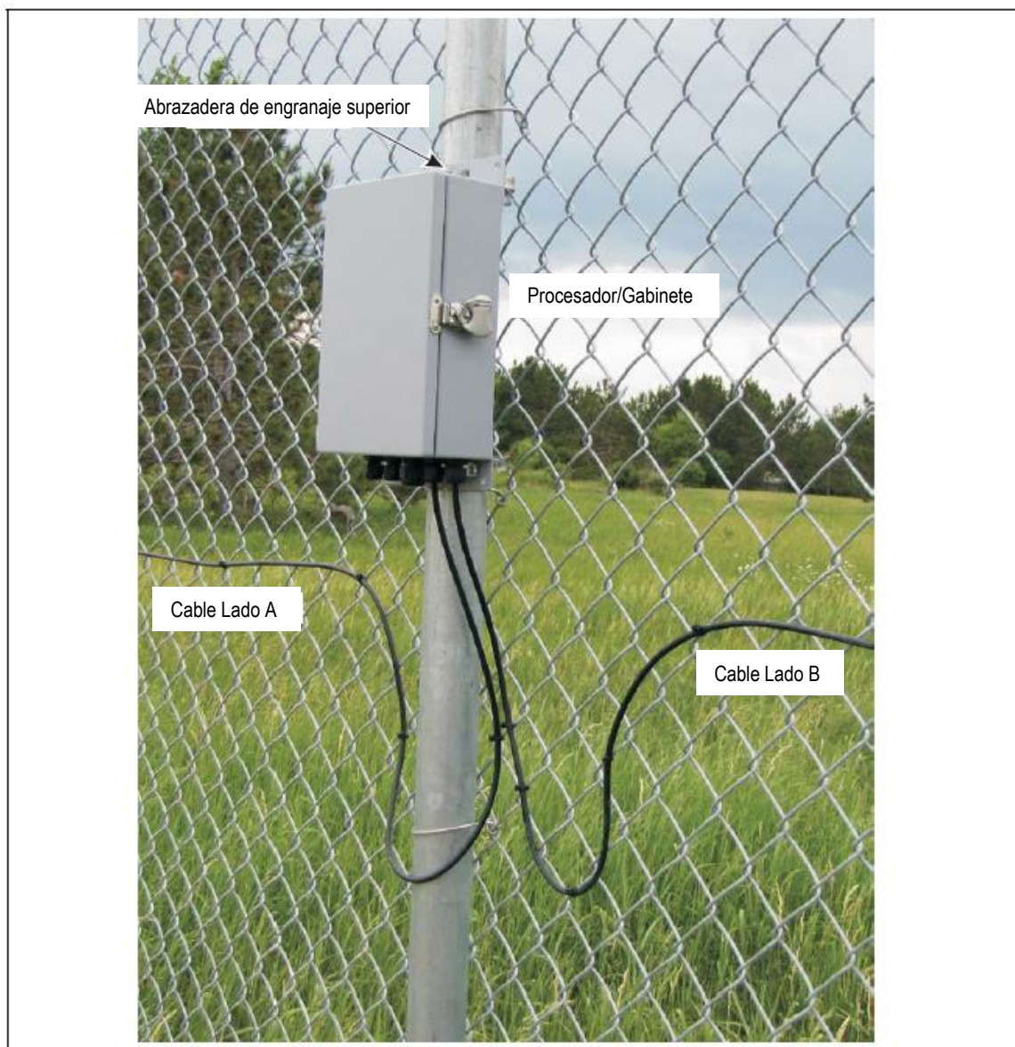
Imagen 51: Procesador FlexZone de doble paso montado en una cerca
