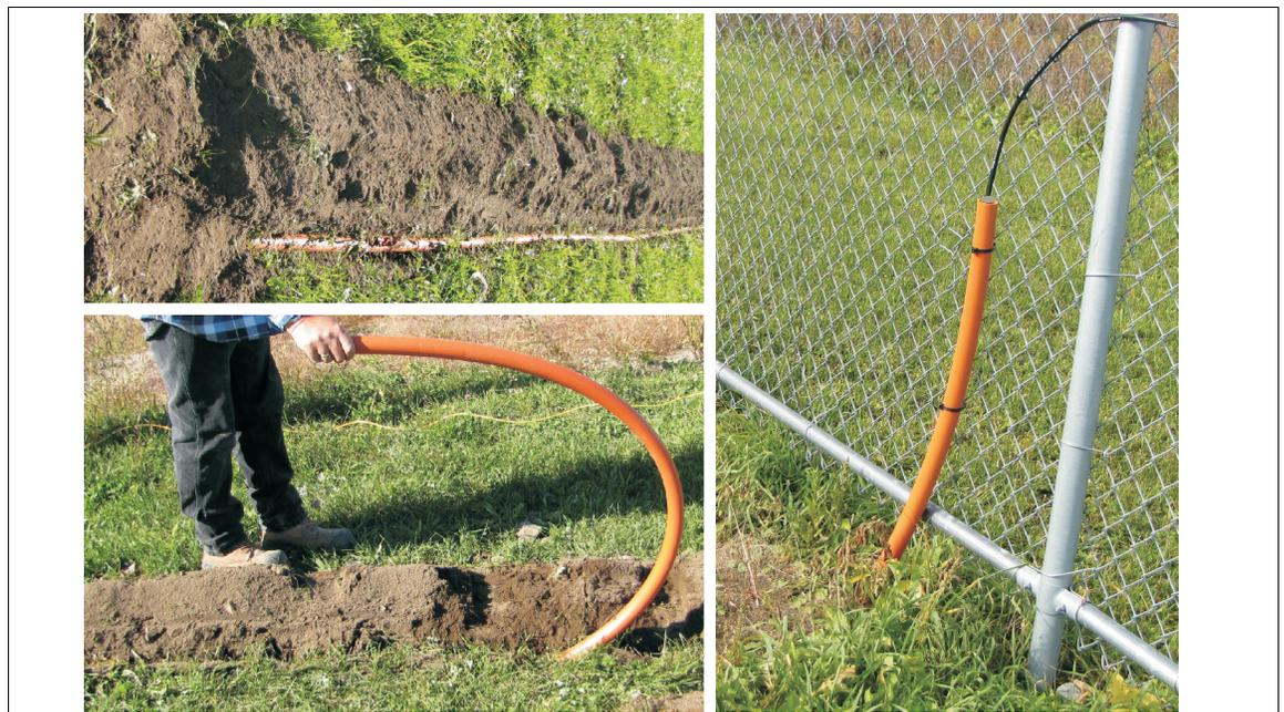
Figure 57 Solid wall conduit
