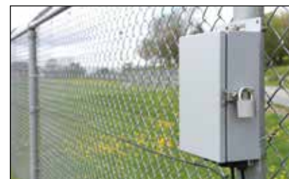
Auswerter am Zaun montiert
